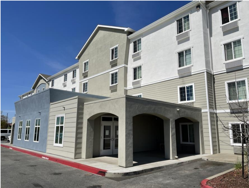
Los Molinos (La Mancha) Apartments
